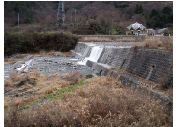
写真 3-1 左岸より本堤を望む(着工前)
