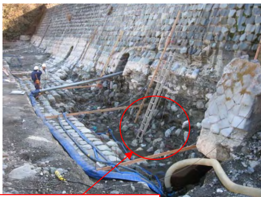
写真 4-2 腹付工・保護工撤去後（1期施工）
